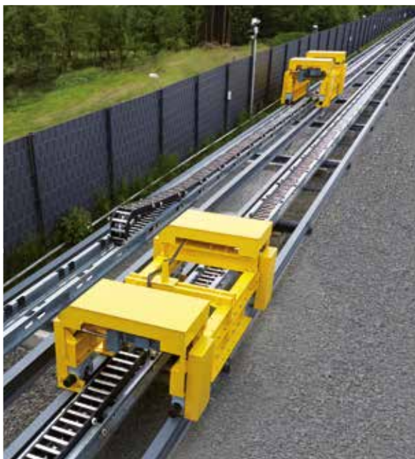
Test outdoor per catene portacavi e cavi
