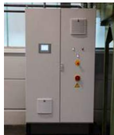
Inštalovanie riadiaceho systému Installation of the control system
