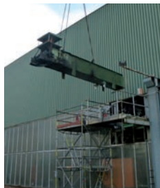
Demontáž existujúcich systémov Disassembly of existing systems
